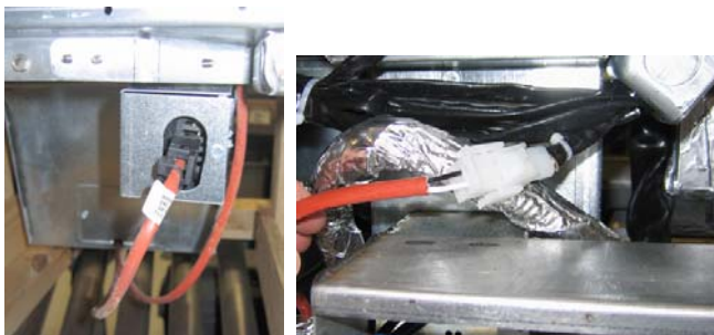
Rysunek 6: Zamontuj i podłącz białe złącza dwustykowe do czarnego złącza w skrzynce uniwersalnej, jak pokazano na rysunku. * Należy zwrócić uwagę, że pozycja czarnego złącza może różnić się od tego na zdjęciu.
